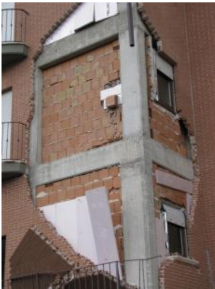
Espulsione del paramento esterno che riveste completamente gli elementi strutturali in c.a.
