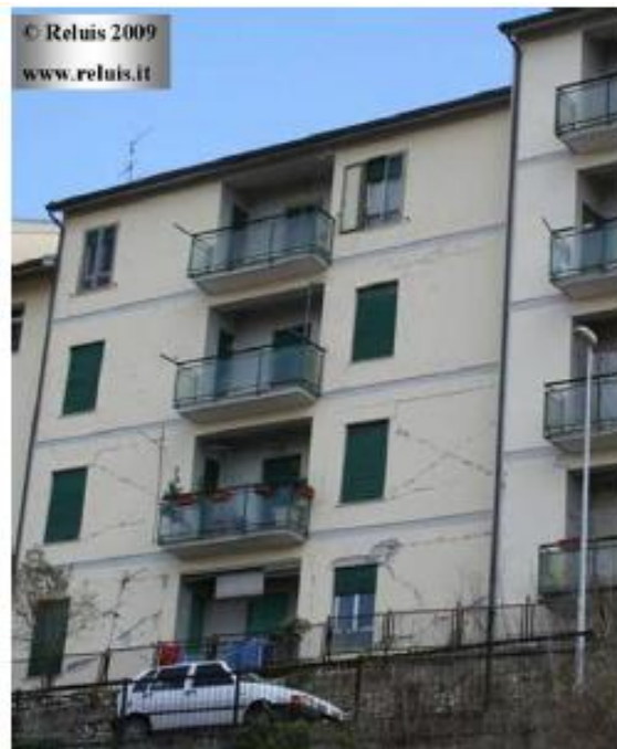
Fessure Diagonali sui tamponamenti di un telaio in c.a.
