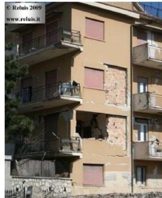
Espulsione del paramento esterno di tamponamento di un telaio in c.a.
