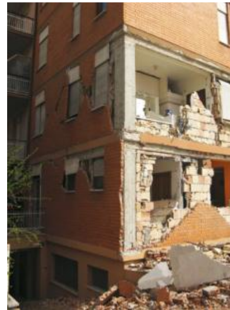
Danneggiamento ed espulsione del paramento esterno che poggia su una soletta della trave e riveste i pilastri in c.a.
